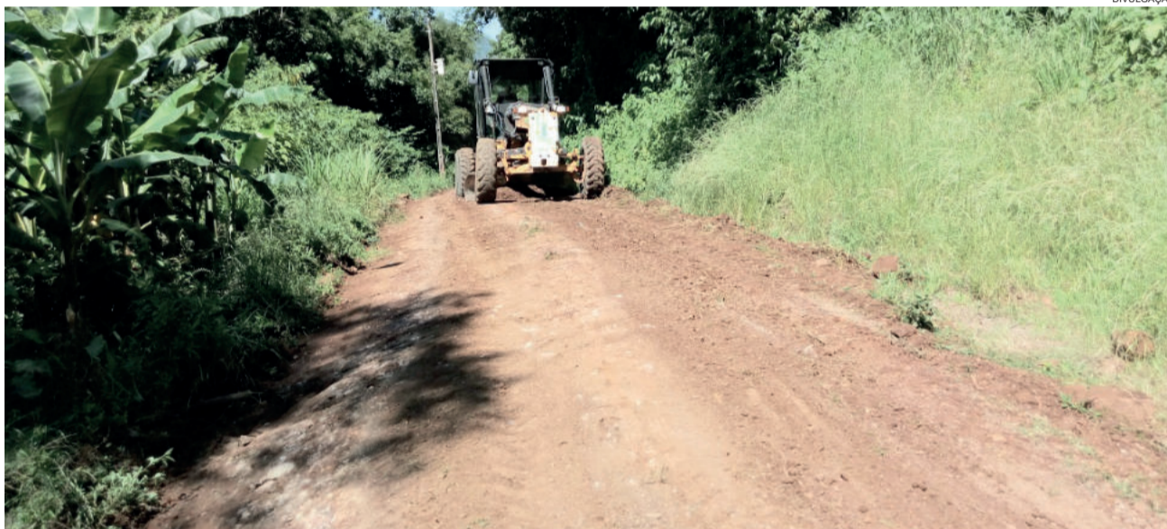
Recuperação da estrada de Boa Vista é uma das obras realizadas
