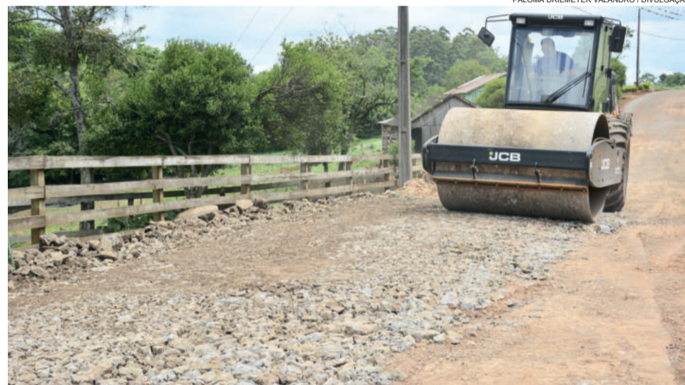
Base para posterior pavimentação asfáltica foi realizada pela Secretaria de Obras, Viação e Interior
