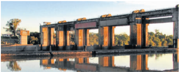
Barragem Bom Retiro
