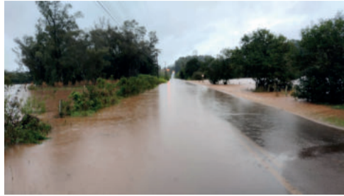
Estrada de L a Ribeiro foi interrompida
