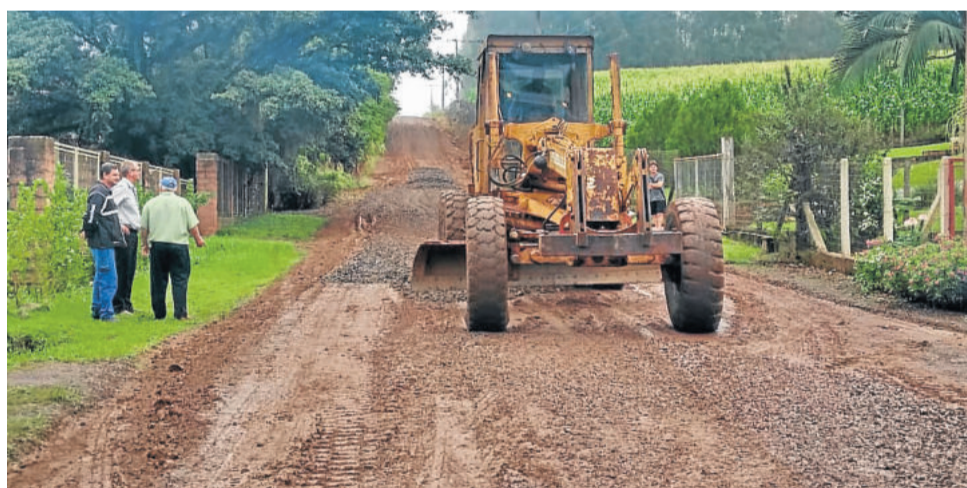
Mutirão de recuperação de estradas realizou melhorias em Linha Wink na semana passada e voltou à localidade ontem
