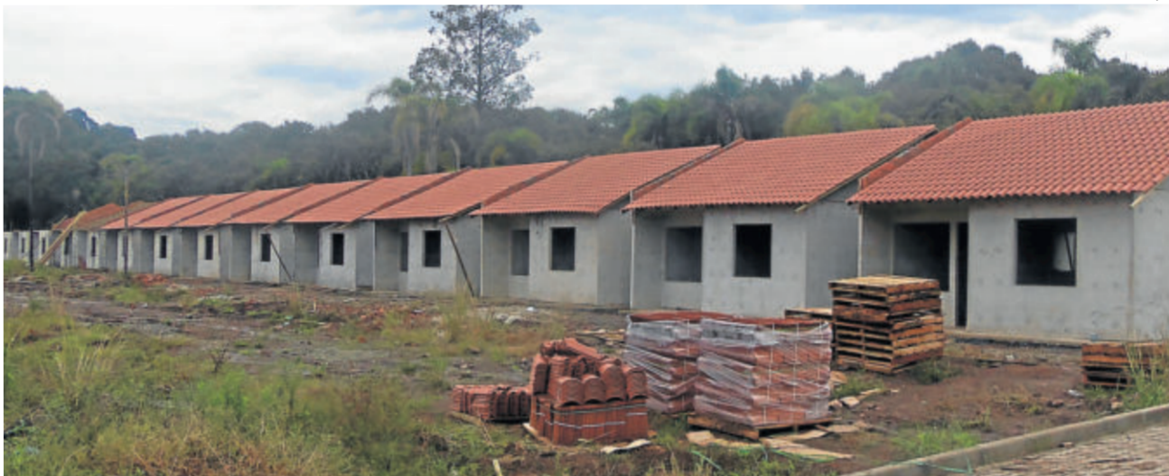
Todas as 50 casas que estão sendo construídas tiveram as paredes concretadas e 22 estão com a cobertura com telhas cerâmicas executadas
