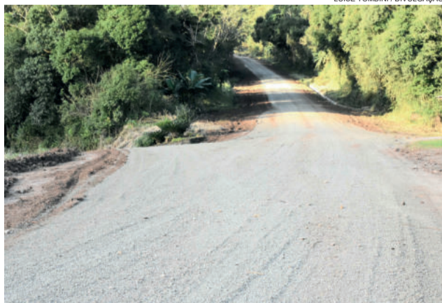
Estrada recebeu patrolamento e camada de brita
