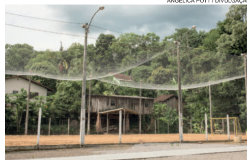
Tela de proteção foi instalada na quadra
