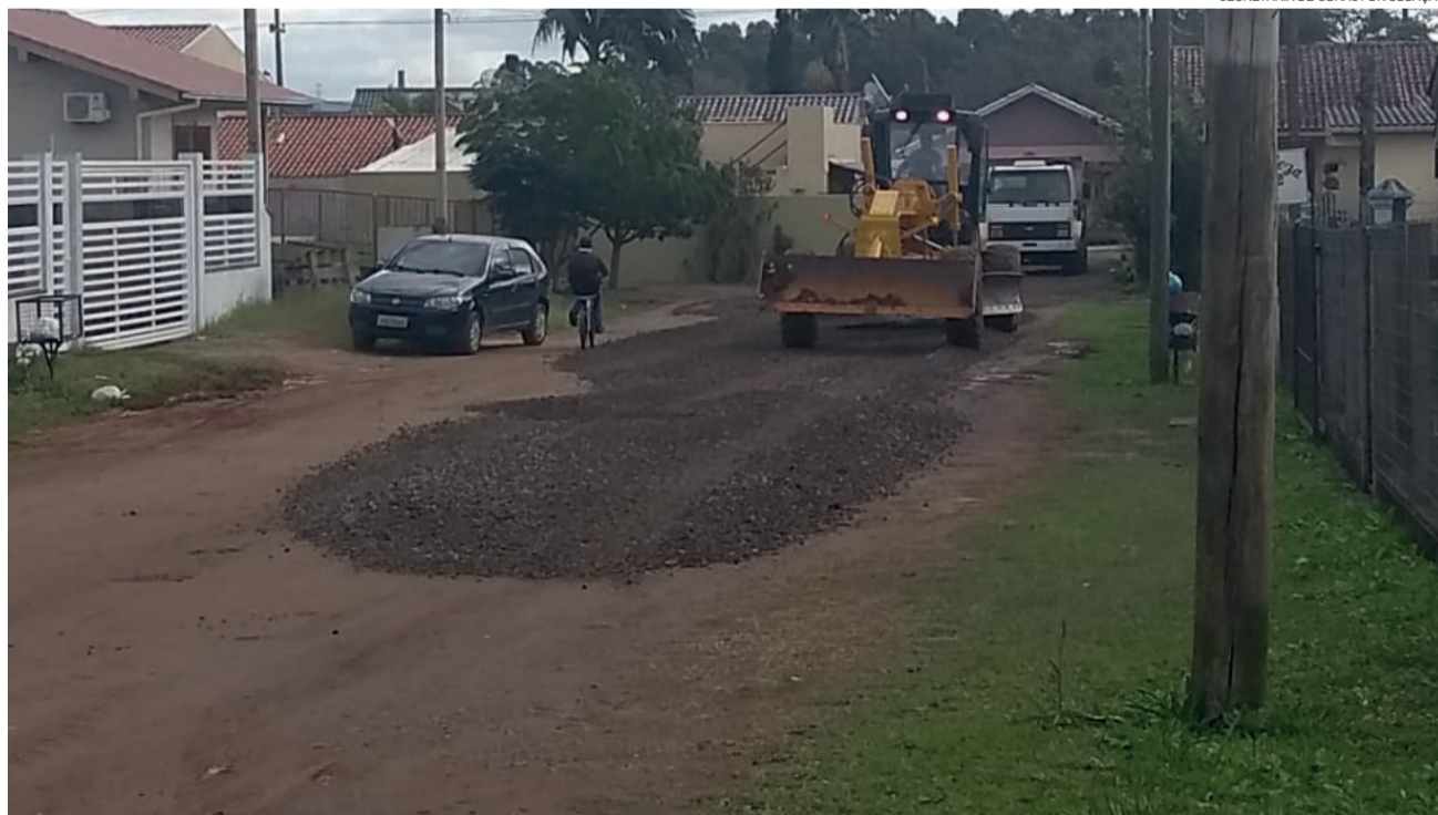
Ruas foram patroladas e receberam cargas de brita
