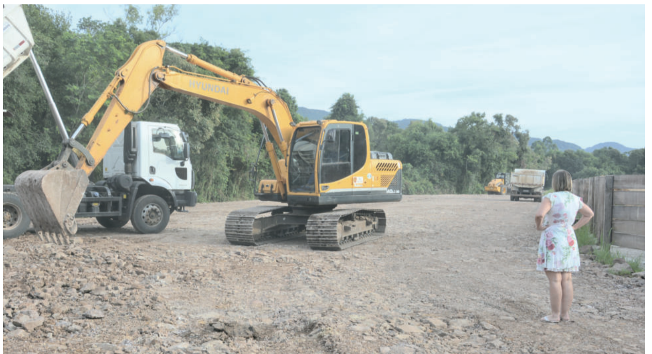
Evanete acompanhou o andamento das obras nesta quarta-feira, dia 30
