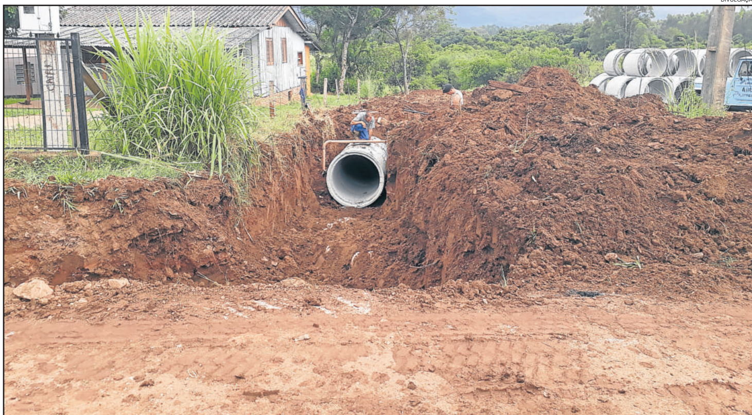
Troca da tubulação deve aumentar em 70% a vazão de água
