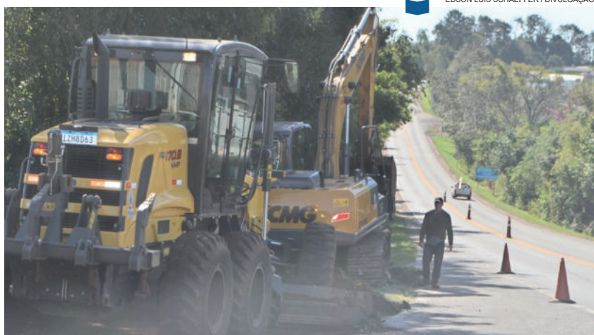
Obras na rótula do Bairro Canabarro iniciaram nesta segunda-feira
