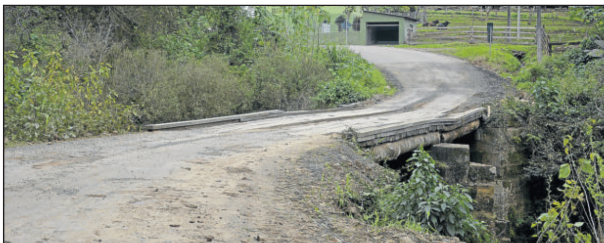
Nova ponte sobre o Arroio Boa Vista é um antigo anseio dos moradores
