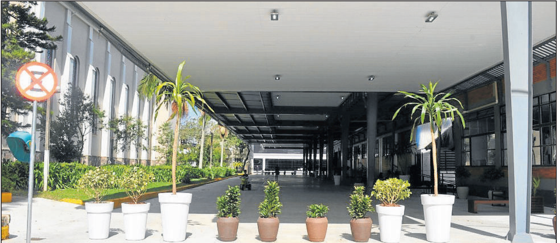
Foram instaladas três câmeras, duas fixas e uma "Speed Dome" giratória
