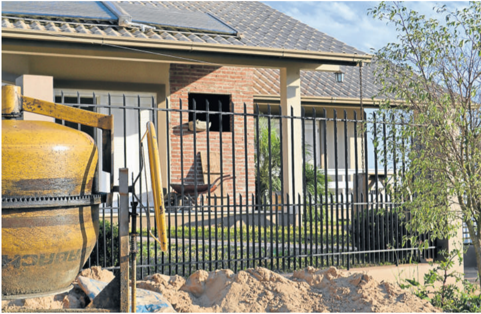
Casa que receberá EMEI está sendo reformada e adaptada
