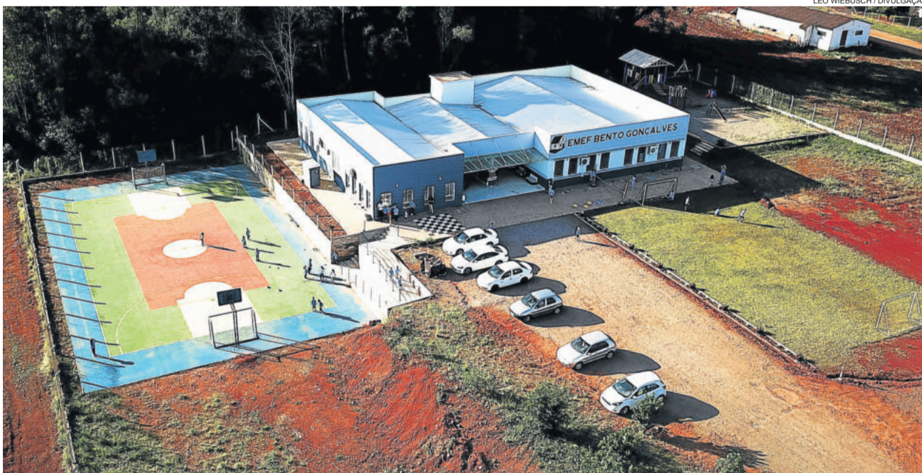
Escola Bento Gonçalves recebeu prédio novo e quadra poliesportiva
