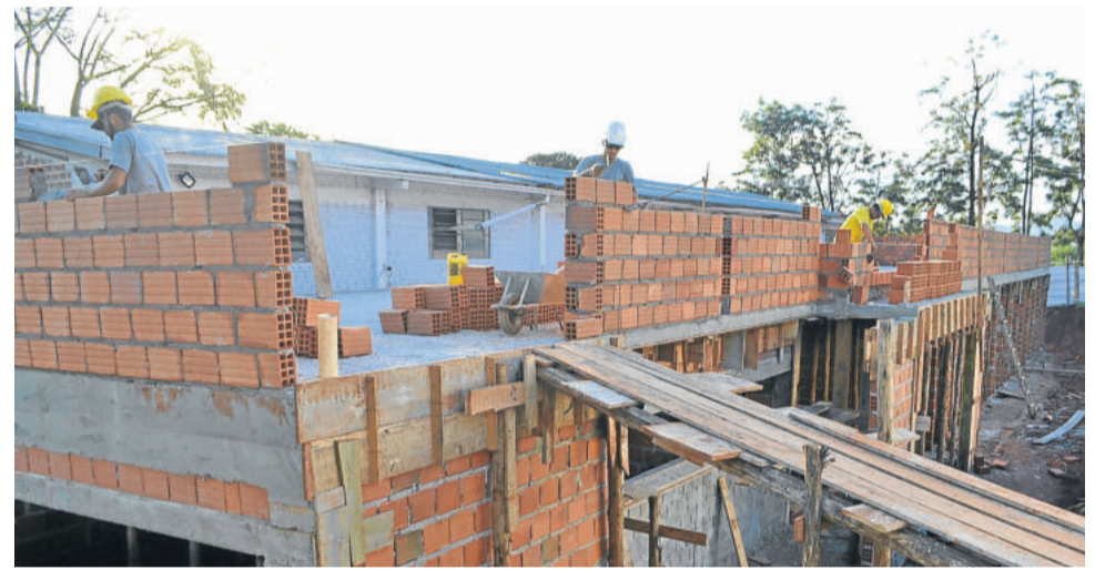
Escola Guilherme Sommer está sendo reformada e ampliada
