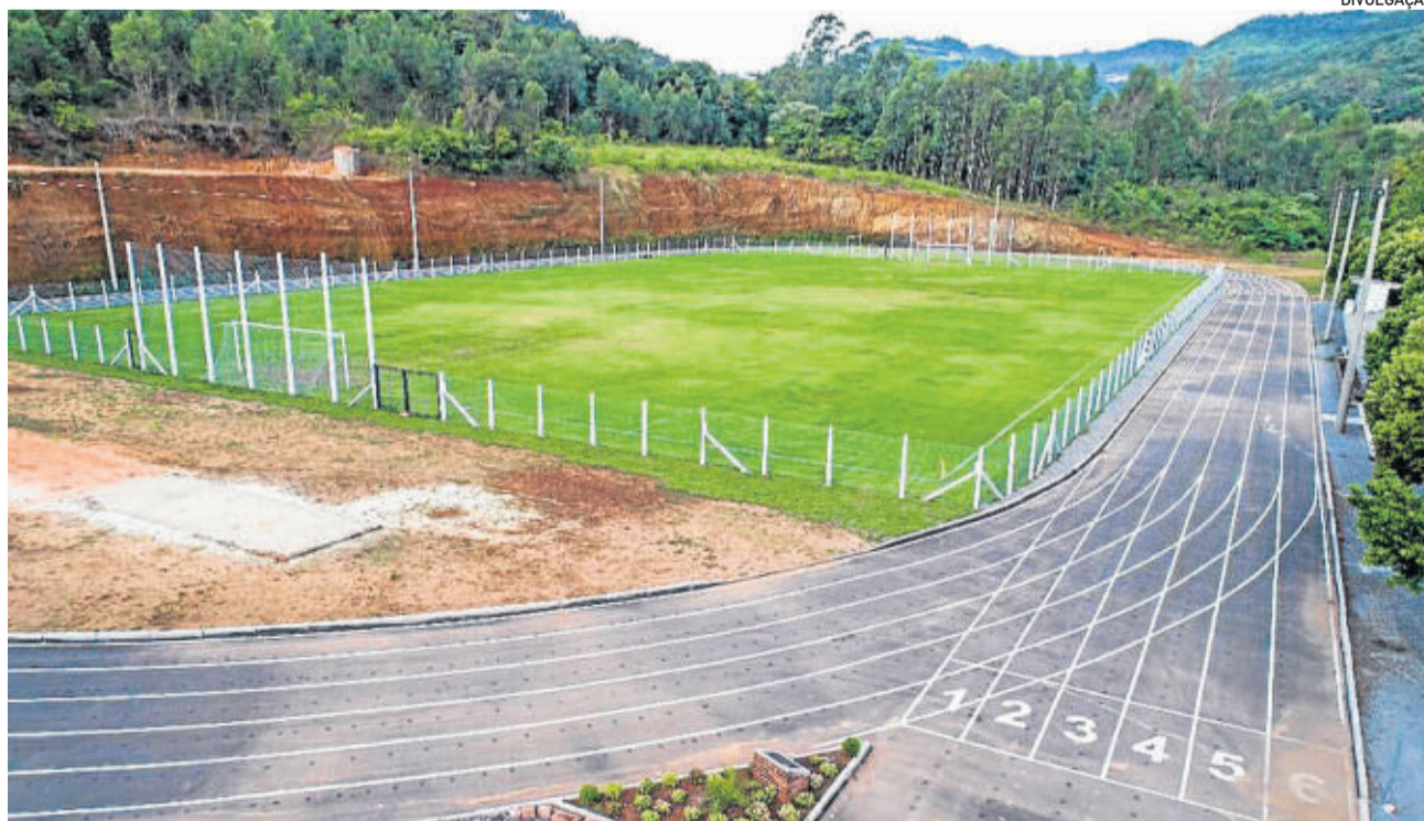
Estrutura está preparada para receber a todos
