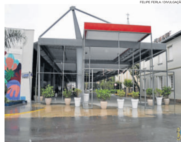
Montagem da estrutura na Rua Coberta se estenderá nas próximas semanas
