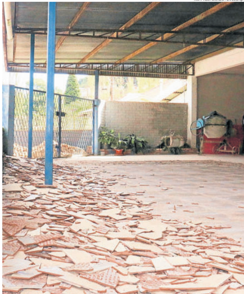
EMEF Visconde de Cairú está recebendo reformas em sua estrutura
