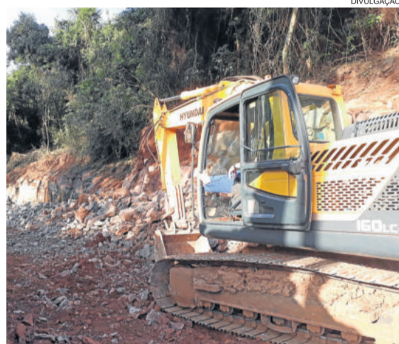
Necessidade de detonação de rocha ainda será avaliada
