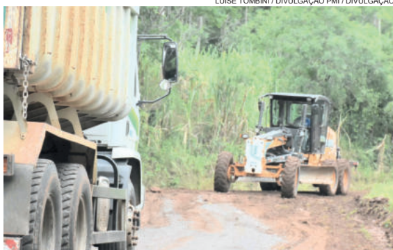
Equipe de Obras atuando na Herval
