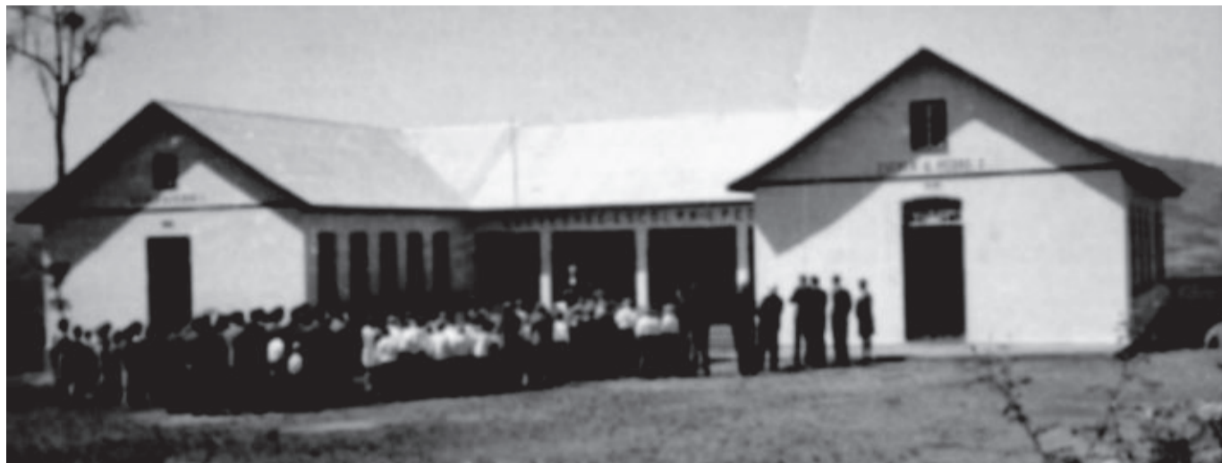
Escola após as ampliações na década de 1960
