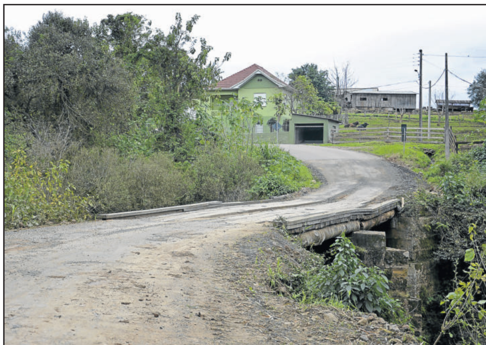
Nova ponte sobre o Arroio Boa Vista é um antigo anseio dos moradores de Linha Frank e Boa Vista
