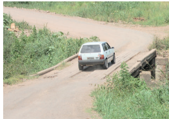
Westfália já elevou o leito da estrada para receber a nova ponte sobre o Arroio Boa Vista
