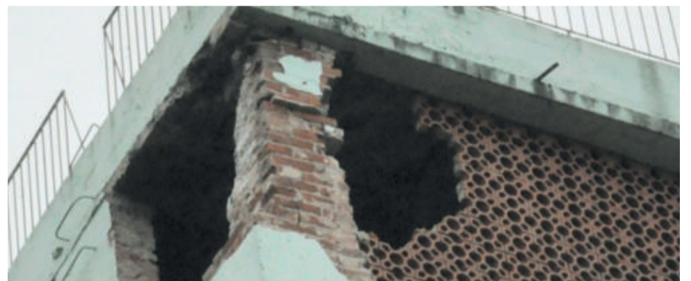
Descarga elétrica atingiu a torre da igreja, parte mais alta do prédio
