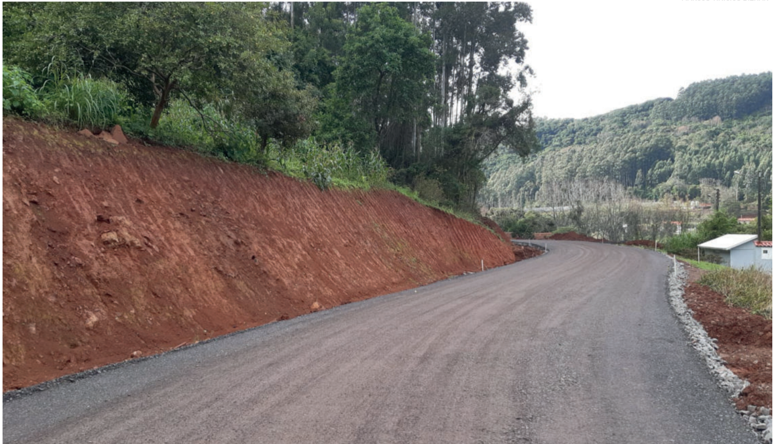
Asfaltamento em fase final
