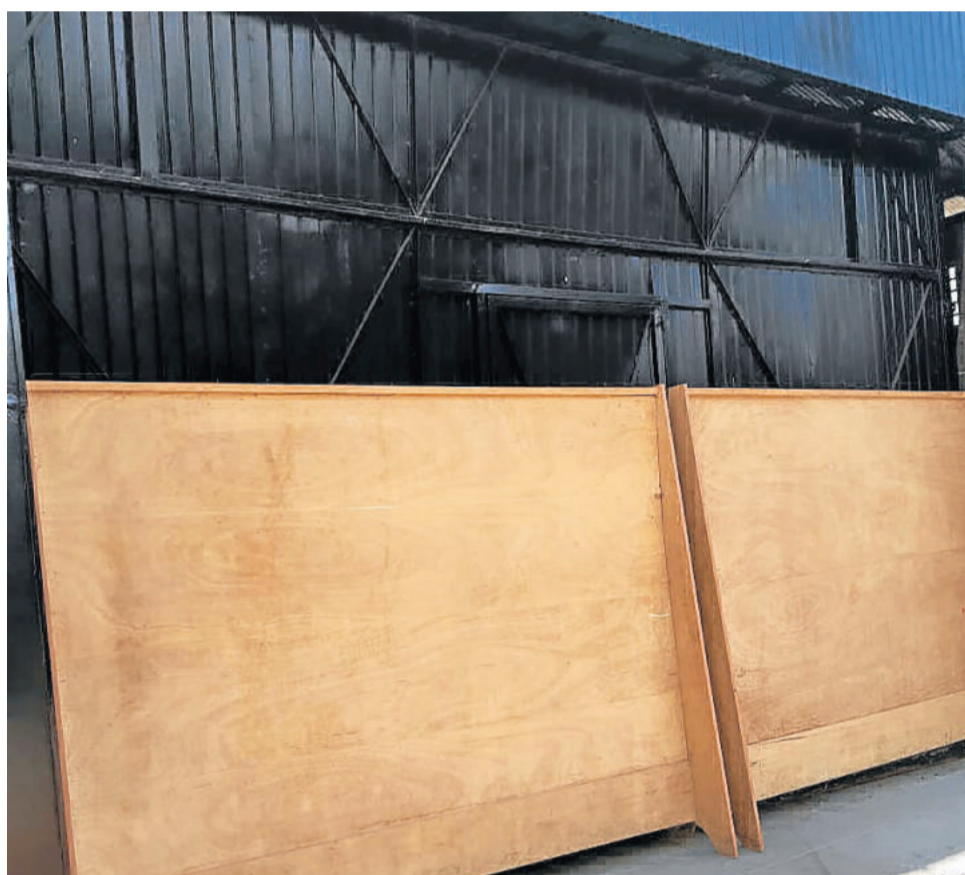
Proteção temporária foi improvisada no local
