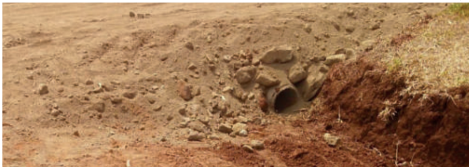
Serviços de colocação de bueiros
