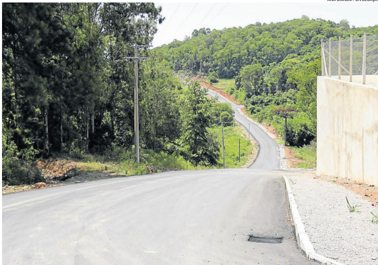
Obras da Perimetral Oeste é uma das maiores obras de infraestrutura
