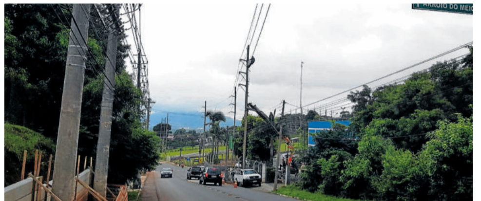
Implantação da estrutura contou com equipes de linha viva
