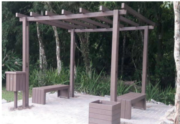
Pergolados instalados no caminhódromo
