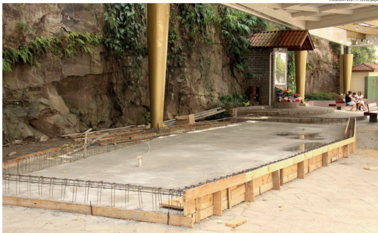
Construção da base da Piccola Garibaldi
