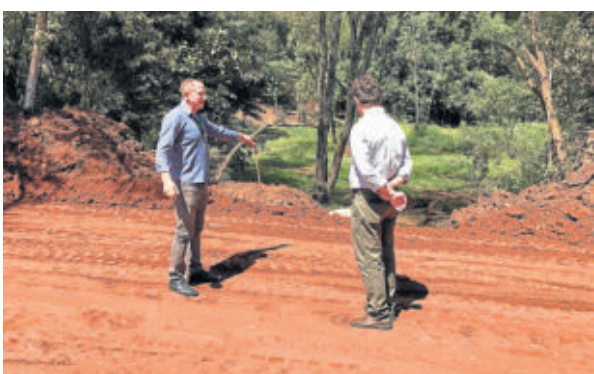
Rua 25 de fevereiro também recebe obras
