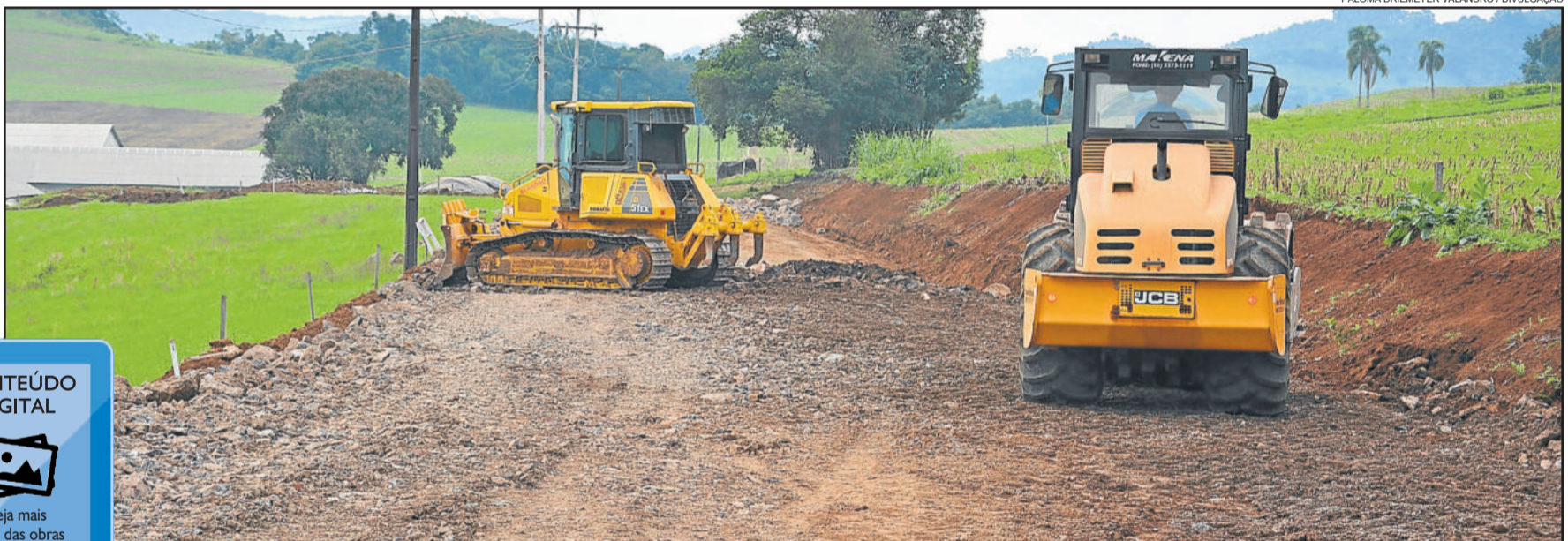
Bom tempo permite que obras sigam em ritmo acelerado
