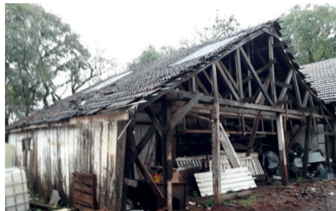
Parte do antigo pavilhão antes de ser demolido
