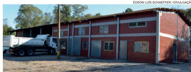
Novo prédio oferece mais segurança e conforto aos servidores
