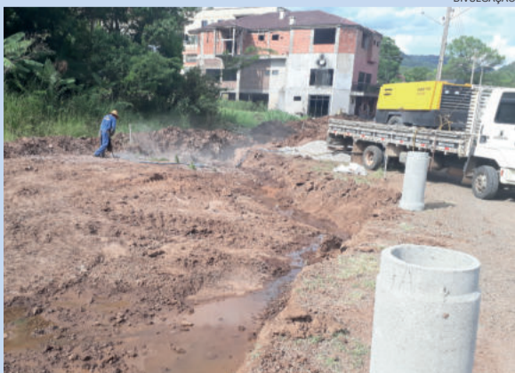
Obras estão em fase inicial
