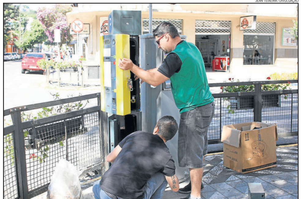
Instalação dos novos equipamentos ocorreu na quinta-feira, dia 30
