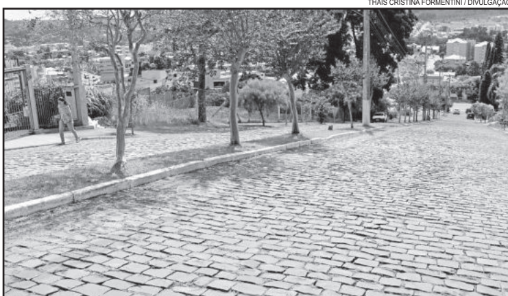
Trecho de 344 metros receberá pavimentação asfáltica, tubulação pluvial, pintura e sinalização
