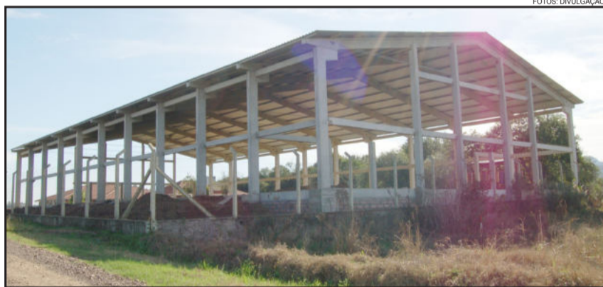
Ginásio de esportes da EMEF Alfredo Schneider já tem primeira etapa concluída
