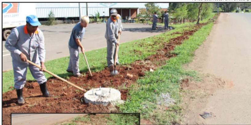
Obra está sendo executada por empresa terceirizada, vencedora do processo licitatório. Bases que sustentarão os 122 postes da iluminação já foram construídas
