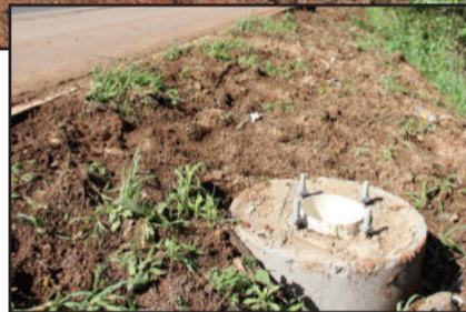
Obra está sendo executada por empresa terceirizada, vencedora do processo licitatório. Bases que sustentarão os 122 postes da iluminação já foram construídas
