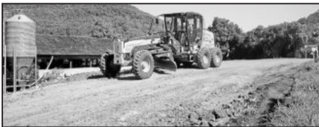
Terraplanagem na propriedade de Luiza Lohmann possibilita a ampliação da produção
