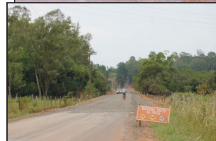
Reta final das obras de pavimentação da Estrada de Linha Ribeiro
