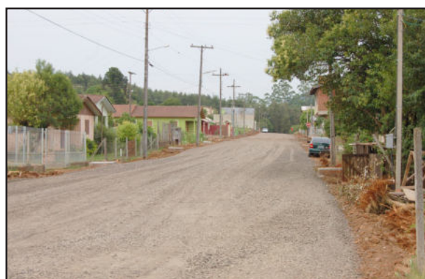
Rua 15 de Novembro em obras
