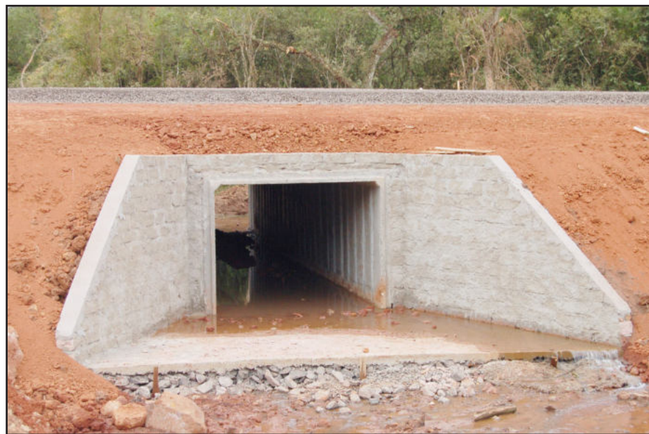
Galerias construídas em Linha Ribeiro
