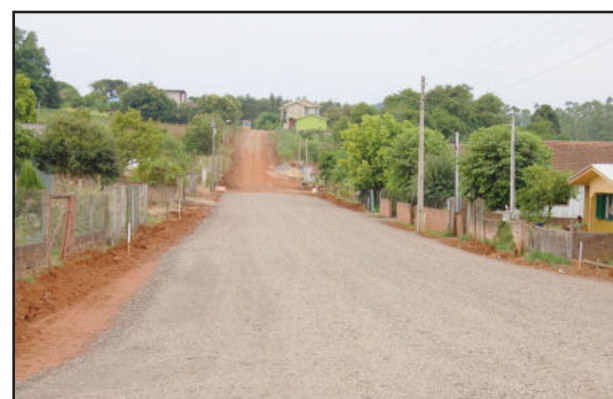
Rua Reynaldo Affonso Augustin em obras
