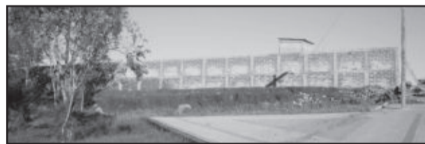
Construção proporcionará maior segurança
