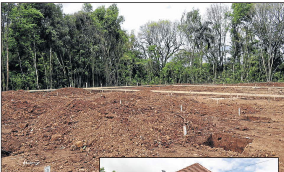
Local onde será erguido o novo prédio da escola
