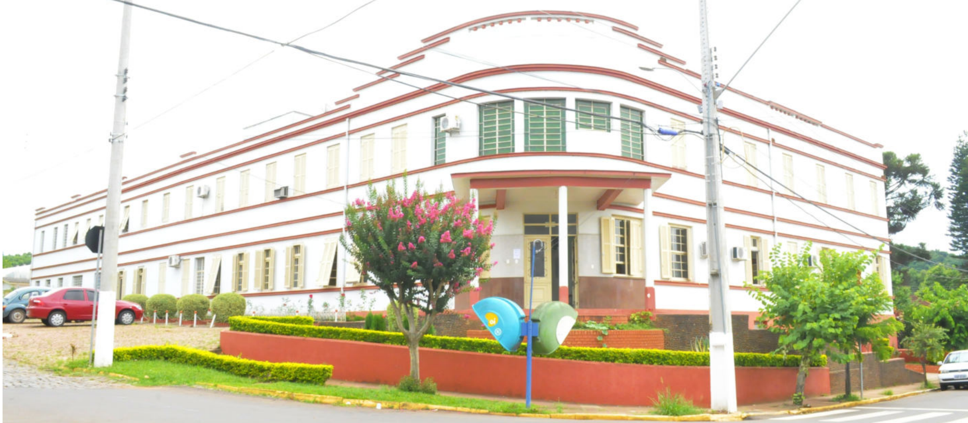
Hospital São João encerrou suas atividades no dia 7, após término do convênio com a Prefeitura e sem acordo de venda do prédio à Administração Municipal
