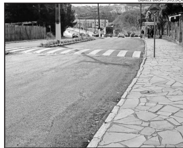
Rua Léo Antônio com as obras concluídas
