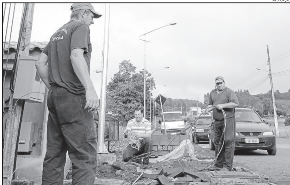
Cabeamento subterrâneo trará mais segurança e beleza ao acesso
