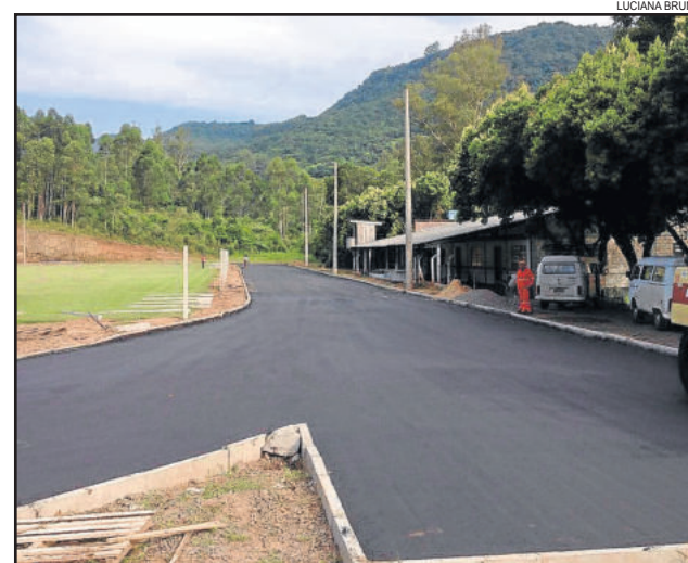
Pista atlética recebeu camada asfáltica
