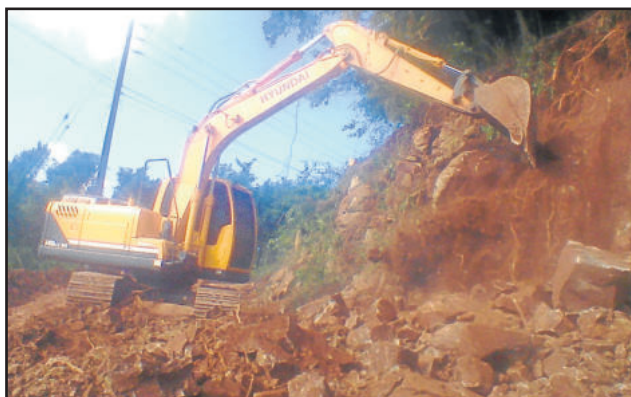
No local, máquinas trabalharam na remoção de rochas e paredões
