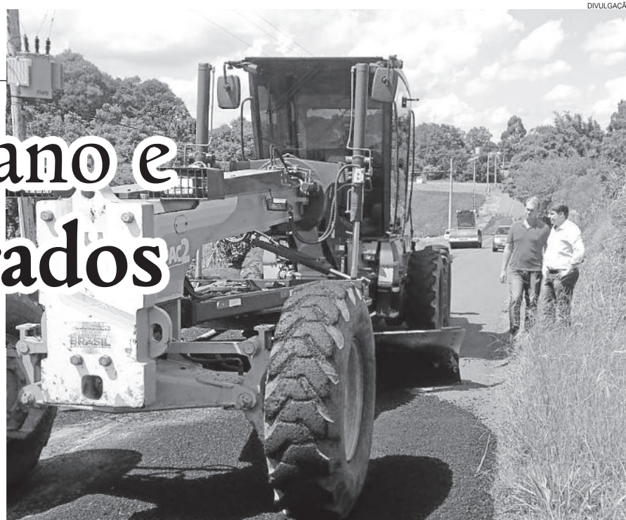
Prefeito Jonatan Brönstrup esteve em São Jacó durante o recapeamento
