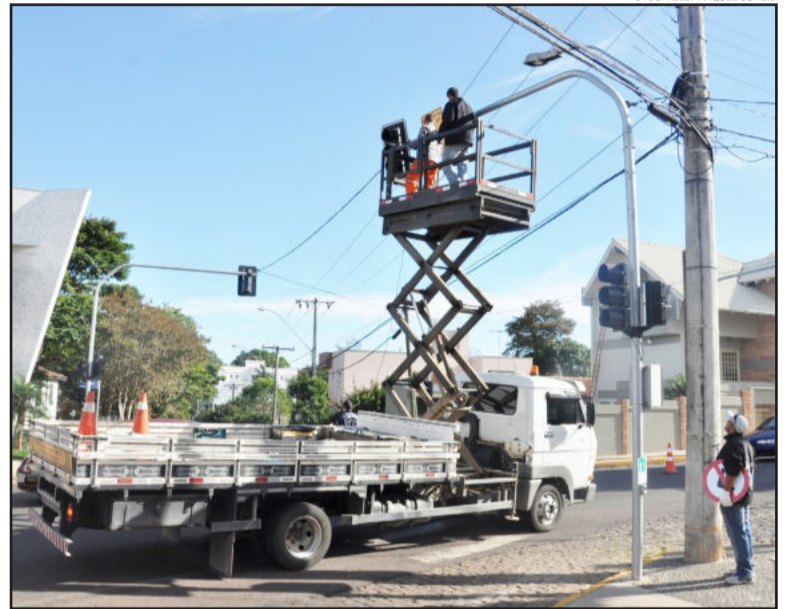
Diversos pontos foram vistoriados durante a operação, a exemplo do semáforo da rua 17 de Dezembro
