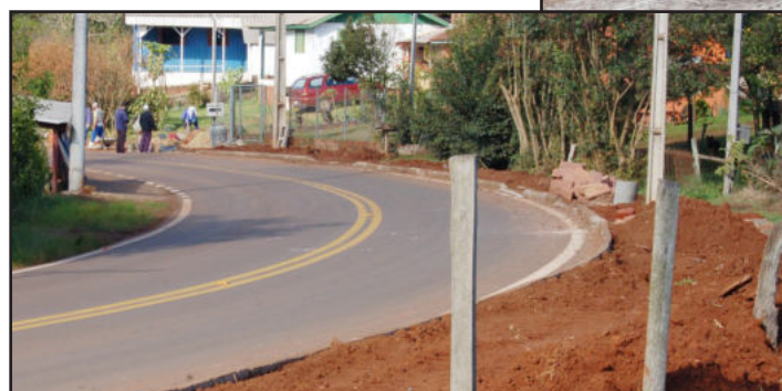
Construção da calçada nas Posses também está em andamento
