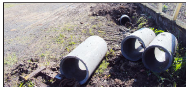
Rua 24 de Março recebe canalização
