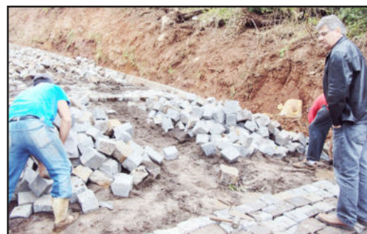
Marasca esteve no local verificando andamento da obra
