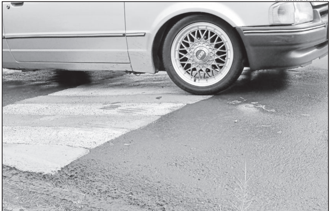
Nos últimos 12 meses, 15 travessias elevadas foram instaladas. Apesar disso, seis mortes
