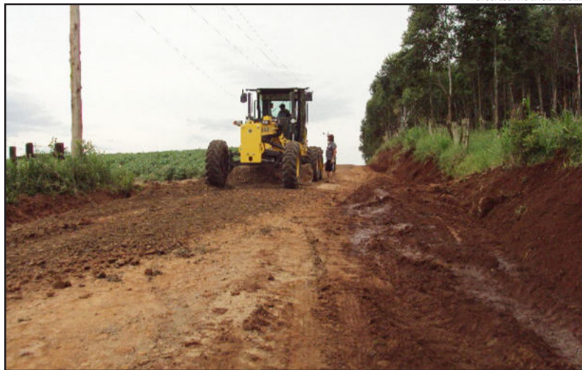
Máquinas da Prefeitura iniciaram a recuperação das estradas do interior
