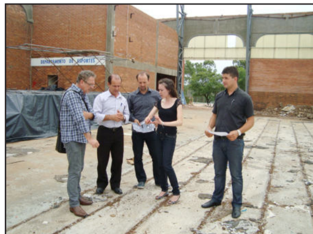
Vistoria ao ginásio constatou obra com problemas
