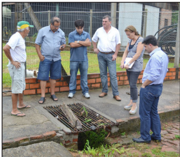
Secretário, prefeito (D) e engenheiros vistoriando estragos
