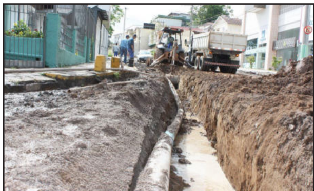
Troca da adutora altera trânsito na Buarque de Macedo
