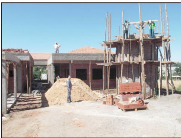
Obra está em estágio avançado
