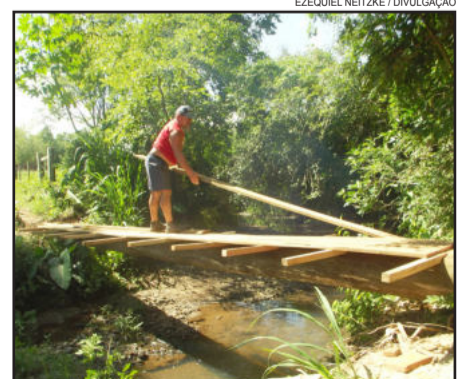
Funcionários trabalharam na colocação de uma passarela na localidade de Picada Flor
