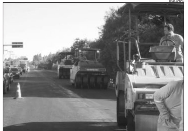
Obras começaram a menos de um mês e estão 20% concluídas
